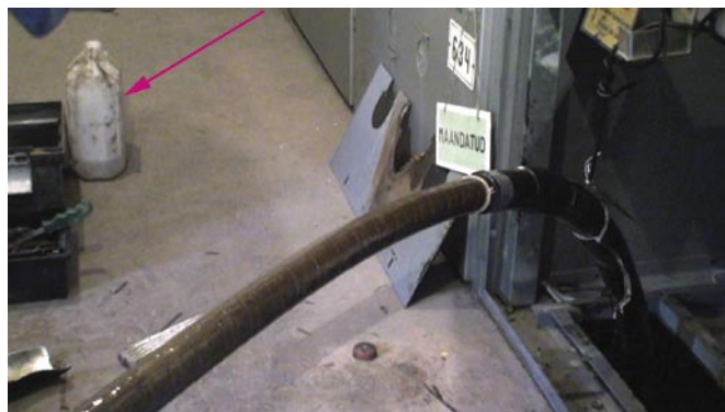
Pilt 4. Töökoht alajaamas. Pildil näitab nool ebasobivas anumas puhastusbensiini
