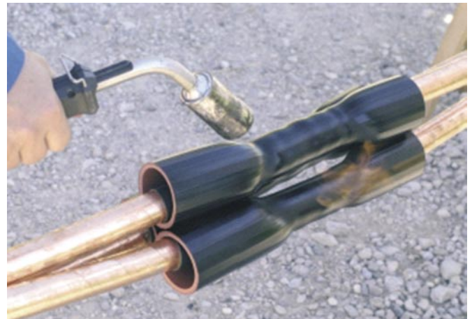
Joonis 5. Torude kahandamine gaasipõleti abil.
