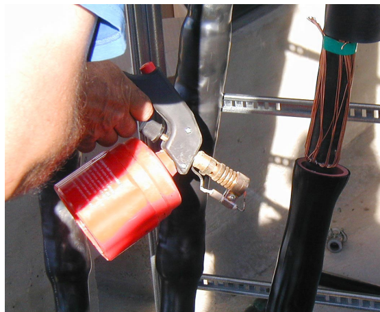
Pilt 1. Vale gaasipõletiga ei ole võimalik korralikku jätkumuhvi teha.
