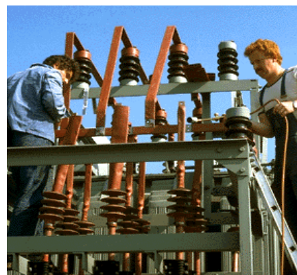
Välisjaotusseadme isoleerimine termokahaneva BBIT toruga.
