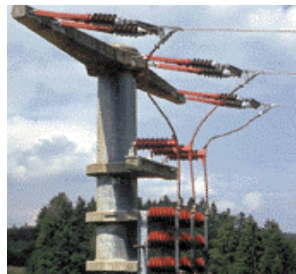
Keskpinge õhuliini üleminekukoht on kaitstud lindude eest.
