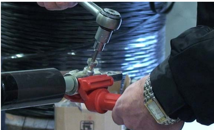
Pilt 4. Kaablikinga paigaldus Elastimold nurkliite paigaldamisel.
