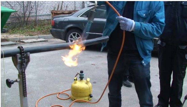
Pilt 1. Enne väliskihi eemaldamist on AHXAMK-W kaabli puhul enamasti vaja kaabli väliskesta eelnevalt gaasipõletiga soojendada.
