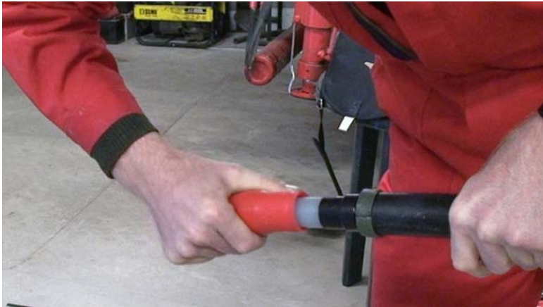
Pilt 3. Väljahtlustusadapter lükatakse kaabli peale
