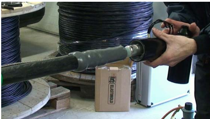
Pilt 5. Puutekindel isoleerkorpus lükatakse kaabli peale.
