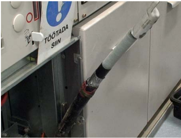
Pilt 2. Vana materjal on eemaldatud, pinnad on puhastatud ja uue otsamuhvi paigaldamine võib alata.
