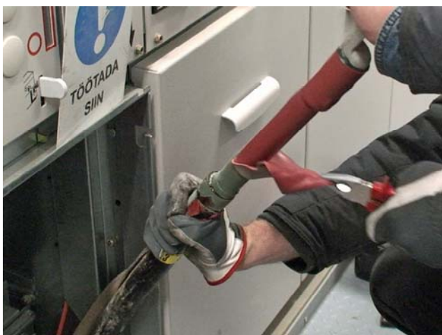
Pilt 1. Probleemse otsamuhvi eemaldamine.
