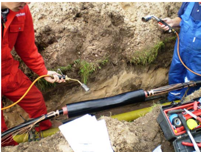
Pilt 2. Paksud torud nõuavad kahandamiseks rohkem aega ja seetõttu võib töö kiirendamiseks kasutada kahte gaasipõletit üheaegselt.
