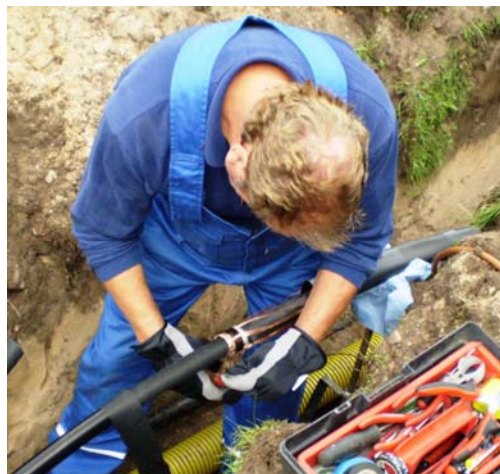
Pilt 3. Ekraanitraatide ühendamine alumiiniumfooliumi kihiga.
