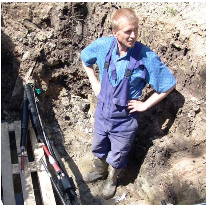
Pilt 3. Harumuhvi (EPKB-12A/1XU-2XU) paigaldamine Karuskosel (Soomaal).
